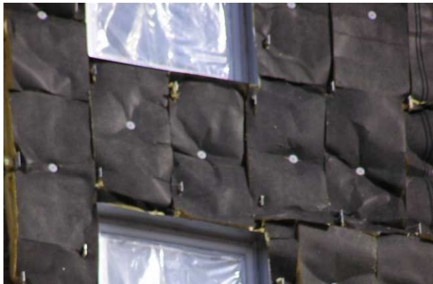
9. Отсутствие перевязки швов (п.9 табл.5)
